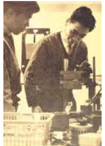
研究装置の多くは手づくりであった。 写真は流動粘度計測定装置。
