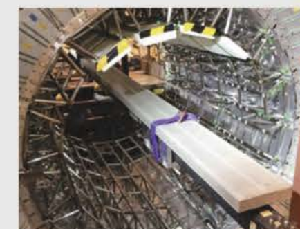
図5 Belle構造体へ設置完了後の様子 円筒状に16台が設置され、支持用トラスが内側に見える。この後、トラスを取り除いて完成した。
